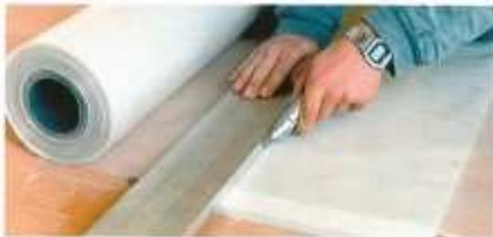
Im Anschluss klappen Sie die doppel-lagige Folie auf und rollen den Folienstreifen auf eine Hilfsleiste.
