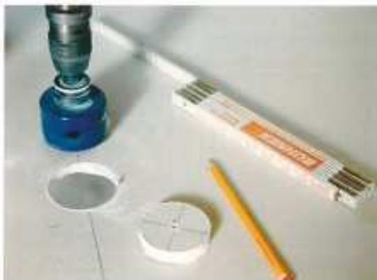
Achten Sie auf ein besonders passgenaues Arbeiten, da durch diese Bohrungen bereits jetzt der maßgenaue Einbau der Elektroschalter und -Dosen vorgegeben wird.
