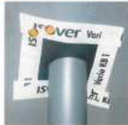
Alle weiteren Anschlüsse oder eventuelle Beschädigungen der luftdichten Ebene/ Folie werden mit dem Spezialklebeband verklebt.
