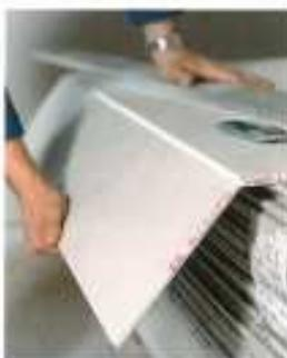
Schneiden Sie mit ihrem Universalmesser und dem Lineal die entsprechende Länge mit einem Schnitt an der Oberfläche durch und knicken Sie die Platte nach unten ab.
