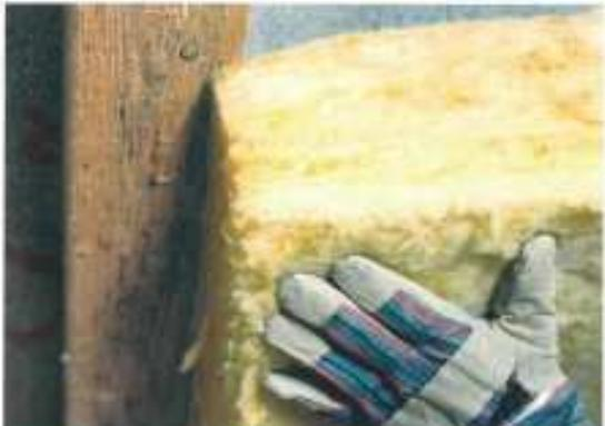
Im Bereich der Sparren und Kehlbalken wird die Holzdicke voll ausgedämmt (Dämmungsdicke entspricht Sparrenhöhe).
