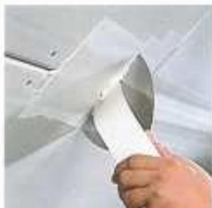
nach unten in die frische Masse einlegen und mit dem sauberen Spachtel bzw. der Glättkelle fest eindrücken. So, dass überschüssiges Spachtelmaterial unter dem Streifen herausgedrückt wird und der Streifen plan aufliegt.
