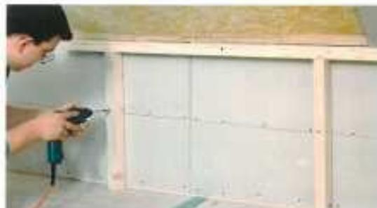
Auf diese Hilfskonstruktion setzen Sie Ihre Gipswerkstoffplatten auf und können diese so mühelos an die Dachschräge drücken.
