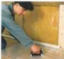
Danach rollen Sie den Folienstreifen langsam entlang der Holzkonstruktion ab und fixieren die Folie mit Ihrem Klammergerät.
