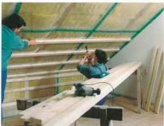
Arbeiten Sie hier stets von unten nach oben und denken Sie bereits bei diesen Arbeitsschritten an das spätere Anbringen der Gipswerkstoffplatten.
