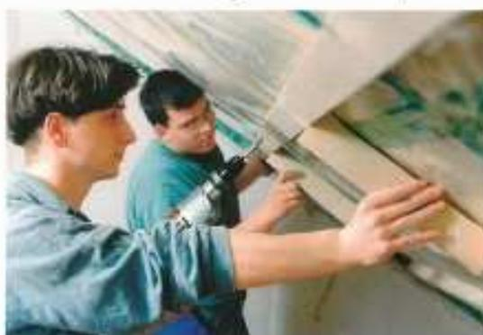
Arbeiten Sie hier ausschließlich mit Schnellbauschrauben (1 Stück, Abmessung 5/80, pro Verbindung), auf keinen Fall mit Nägeln.
