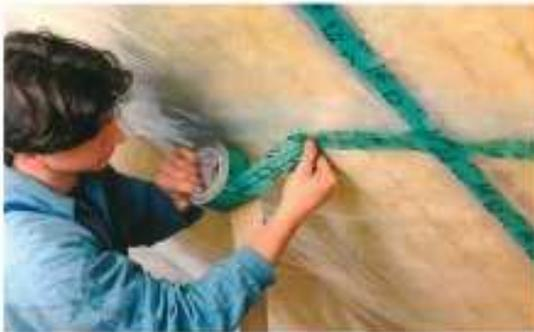
Wie am Anfang des Kapitels beschrieben, ist die Dampfbremse mit der zusätzlichen Funktion einer luftdichten Schicht an allen Dach- und Deckenflächen einzubauen, die den Wohnraum nach außen abschließen. Wird z. B. das Dachgeschoss vorübergehend nicht ausgebaut, ist vollflächig an der gesamten Decke über EG bzw. OG eine entsprechende Dampfbremse einzubauen.
