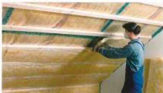
Beim Zuschnitt empfiehlt es sich, mit einem Lineal stets mehrere Dämmmatten auf einmal zuzuschneiden.
