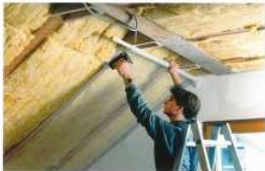
Führen Sie die erste Folienlage über den Balken und überlappen die darauf liegende Folienlage mittig des Balkens bzw. der Holzkonstruktion.
