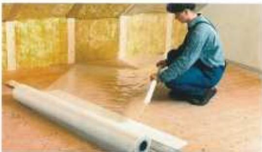
Beim Einbau beginnen Sie mit einem Folienlappen auf der Geschossdecke, den Sie mit dem Klammergerät auf dem Deckenbelag fixieren und mit dem Spezialklebeband mit der Folie, die beim Aufbau des Hauses um die Decke gelegt wurde, verkleben.
