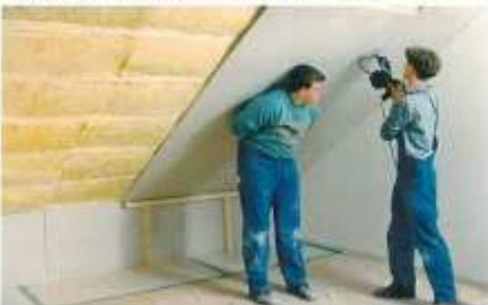
**Achtung!** Unterschiedliche Schnellbauschrauben für Gipskarton- und Gipsfaserplatten.
