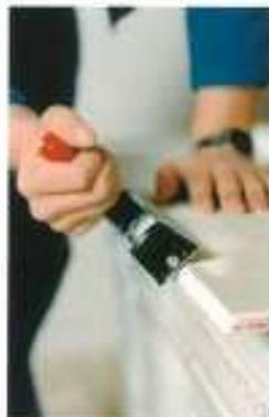
Bei Gipsfaserplatten muss die Kante nur dann gehobelt werden, wenn sie als Sichtkante/Außenecke ausgebildet werden soll. Eine Bruchkante beeinträchtigt die spätere Verlegung nicht.
