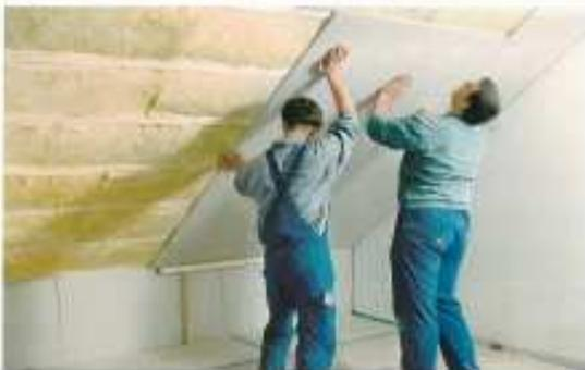
Nun ist es ein Leichtes, die Platte mit Schnellbauschrauben zu fixieren.
