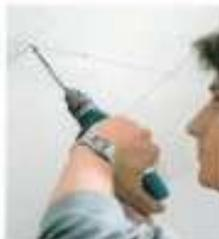
An diesen Markierungen schrauben Sie mit einem Akkuschauber die Schnellbauschrauben ein.
